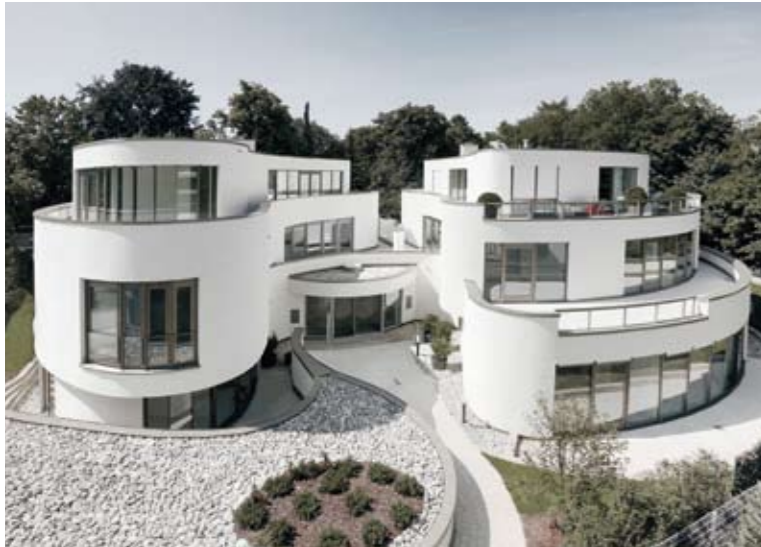
Eigentumswohnungen, Oberföhringer Str., München
